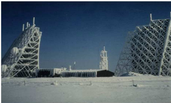
Station Feldberg (AFEZ), gelegen im Süden von Deutschland, mit Troposcatterverbindung zu der Station Dosso dei Galli (IDGZ)
