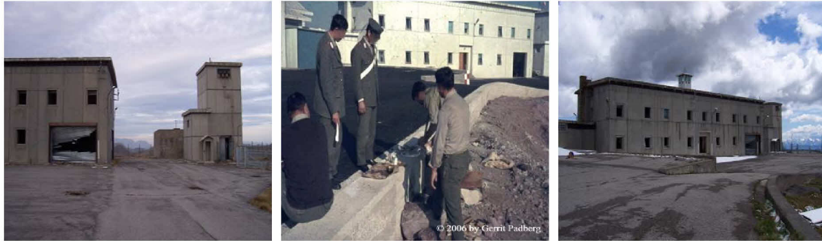
Garageneinfahrt mit der Station von ENEL (2006) Das Personal Gebäude aus der gleichen Sicht ( 2006 )
