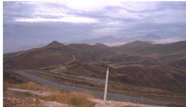
Die gleiche Militär Strasse von der Station ( 2006 )
