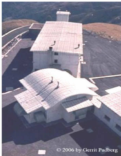
Personal Gebäude ohne Wachturm mit Maschinen Gebäude ( 1970 ) ausgeführt als „ Faradayscher Käfig „
