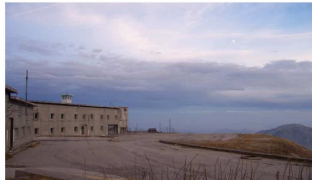
Das Personal Gebäude und der hintere Platz (2006)
